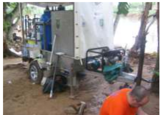
Installation von Wasseraufbereitungsanlagen. Galle, Sri Lanka)
